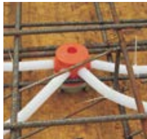
Пример установки в горизонтальной опалубке.
