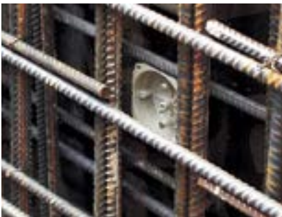
Крышка KBV, прикрепленная на опалубке.
